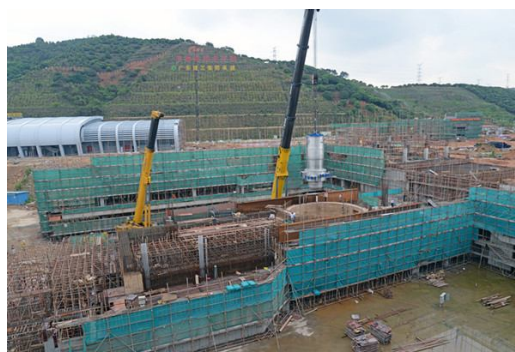
图 4 CSNS 施工现场 [30] Fig.4 Construction site of CSNS [30]
